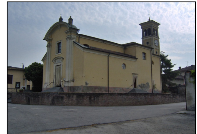
rilevo fotografico esemplificativo degli edifici
