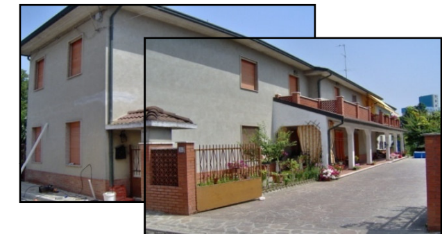
rilevo fotografico esemplificativo degli edifici
