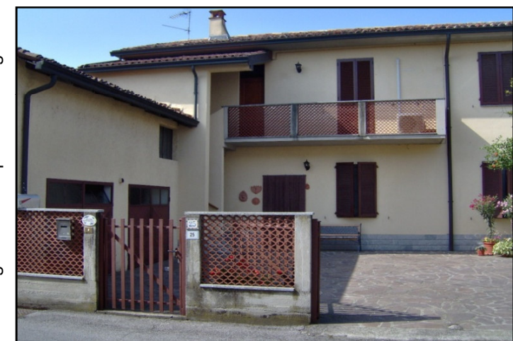
rilevo fotografico esemplificativo degli edifici
