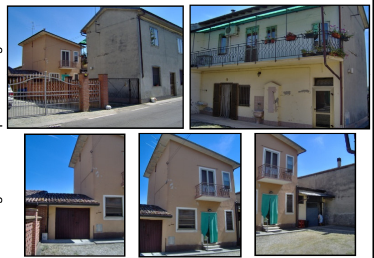
rilevo fotografico esemplificativo degli edifici
