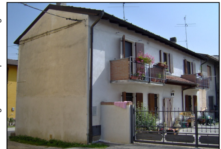
rilevo fotografico esemplificativo degli edifici
