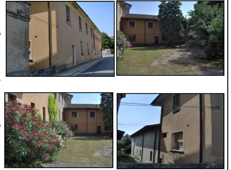
rilevo fotografico esemplificativo degli edifici
