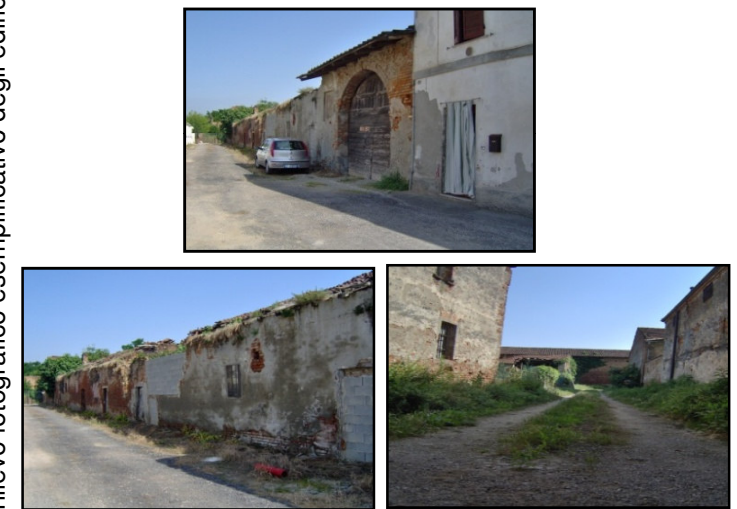
rilevo fotografico esemplificativo degli edifici
