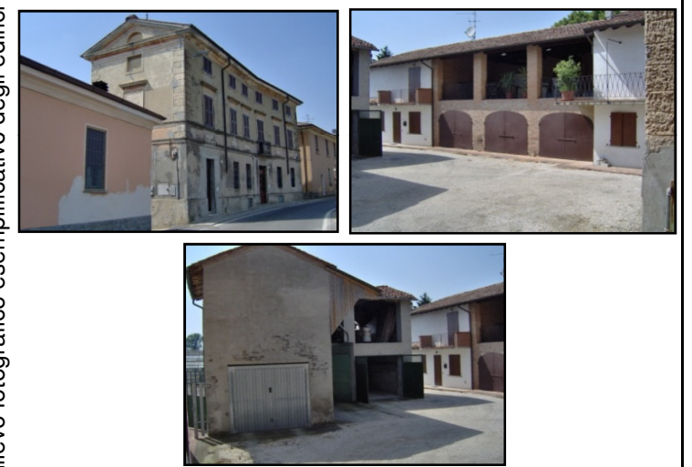
rilevo fotografico esemplificativo degli edifici
