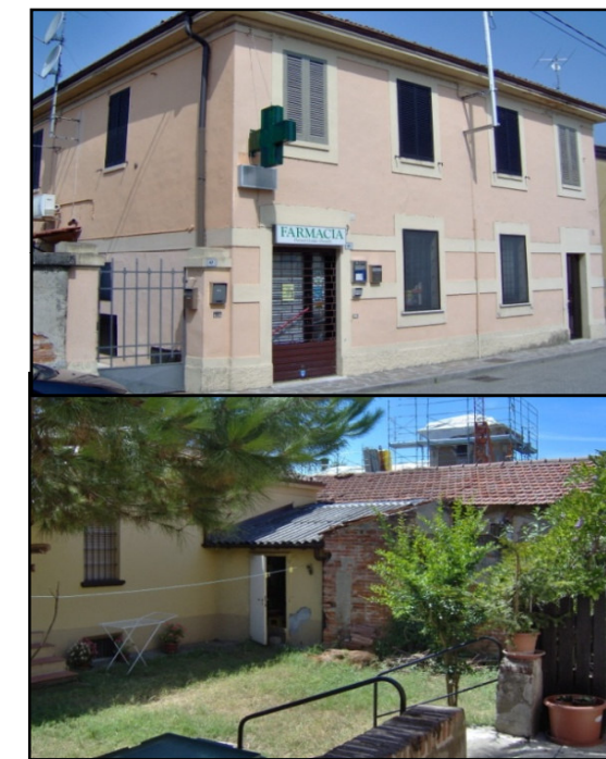
rilevo fotografico esemplificativo degli edifici
