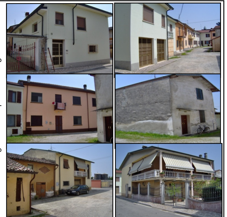
rilevo fotografico esemplificativo degli edifici
