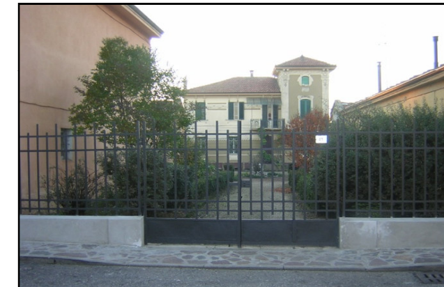
rilevo fotografico esemplificativo degli edifici
