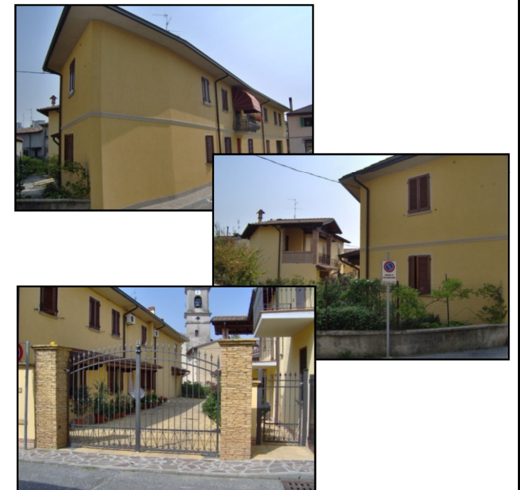
rilevo fotografico esemplificativo degli edifici
