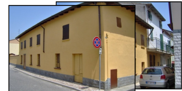
rilevo fotografico esemplificativo degli edifici
