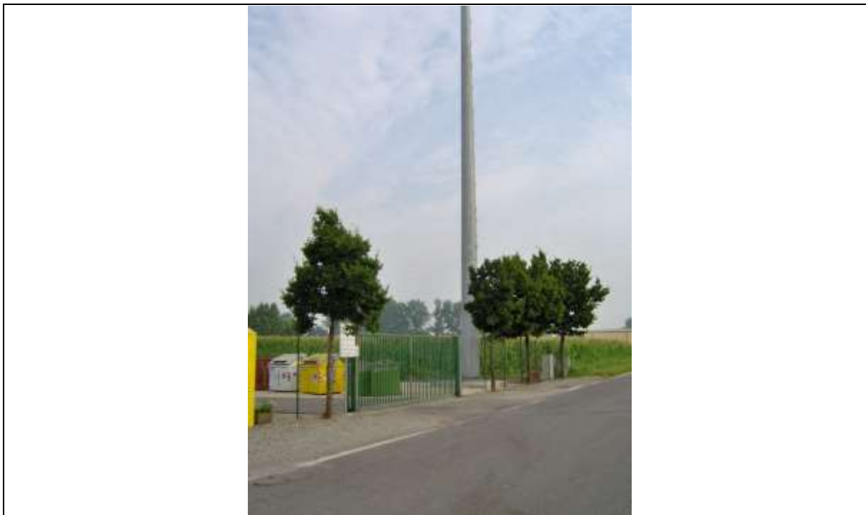
Figura 22 - antenne radio mobile
