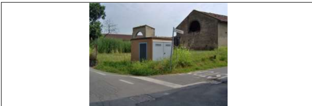
Figura 23 - cabina elettrificazione (immagine esemplificativa)
